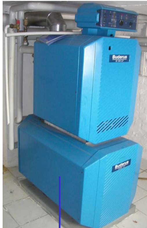
indirekt beheizter Speicher (liegende Ausführung, untergebaut)
