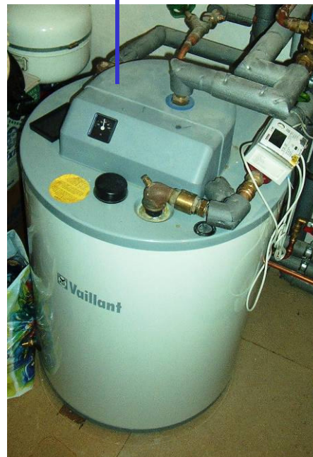
indirekt beheizter Trinkwarmwasserspeicher
