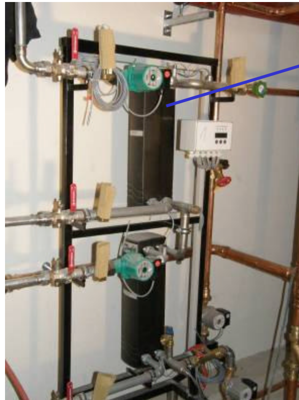
Durchlaufwassererwärmung mit Wärmeübertrager (36-Familienhaus, je ca. 80 kW Leistung)
