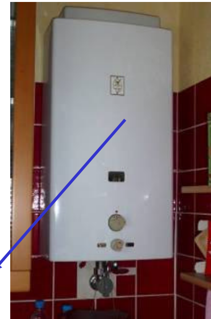
Gasdurchlauf- wassererwärmer
